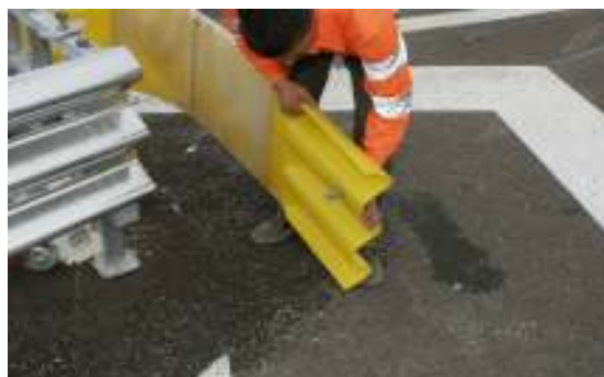
Figura 22 - Posizionamento naso
