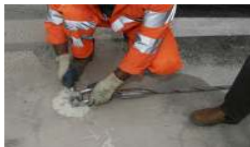
Figura 17 - 18 – Collegamento funi a pali d'ancoraggio
