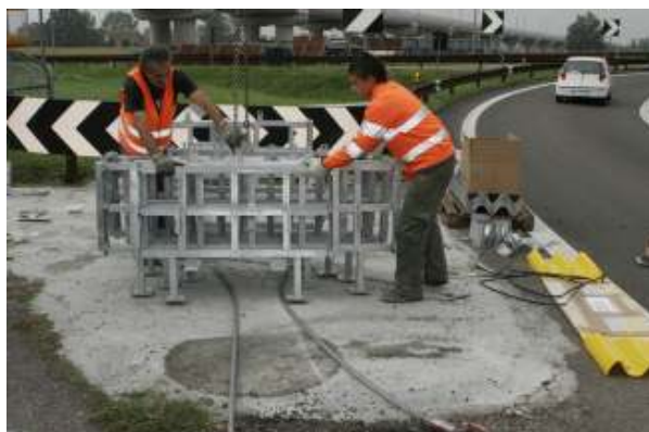
Figura 11 - 12 – Posizionamento supporti intermedi
