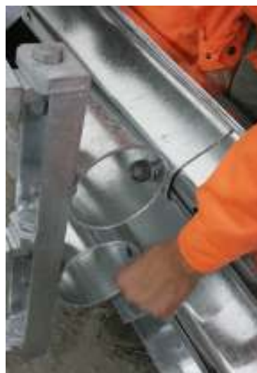
Figura 16 - 17 – Posizionamento lama 3N
