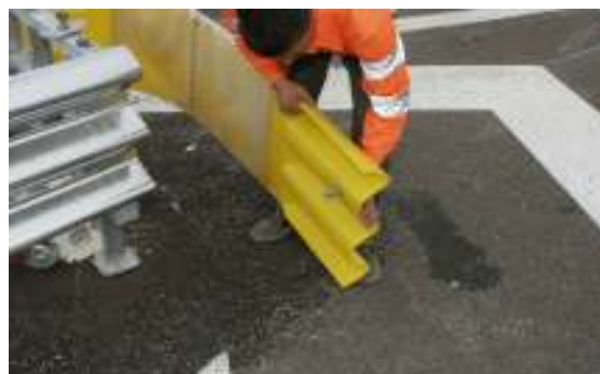
Figura 22 - Posizionamento naso
